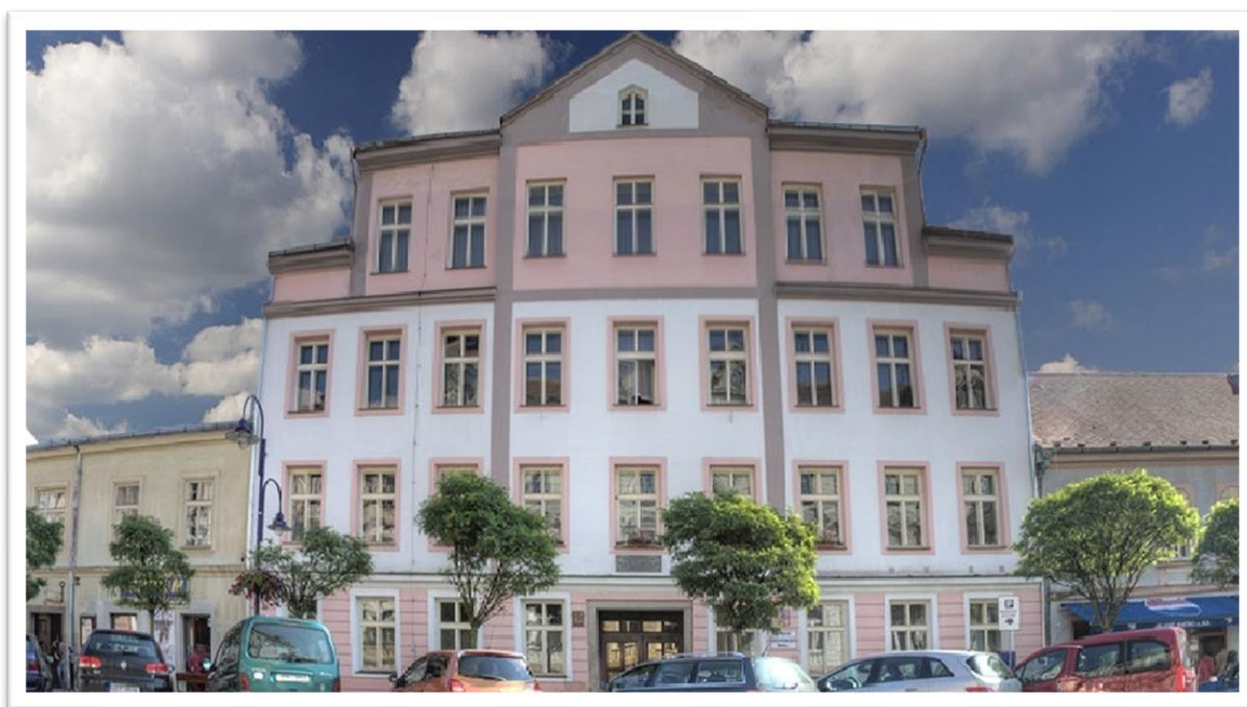
Budova školy - pohled přední
