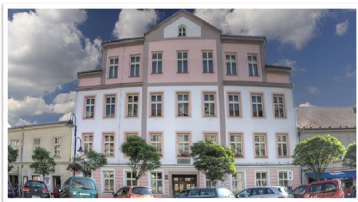
Budova školy - pohled přední
